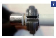
Prensar con tenazas o anillos tipo U. Posicionar el lateral de la mordaza junto al anillo de plástico y realizar el prensado. El anillo de plástico no debe prensarse.
